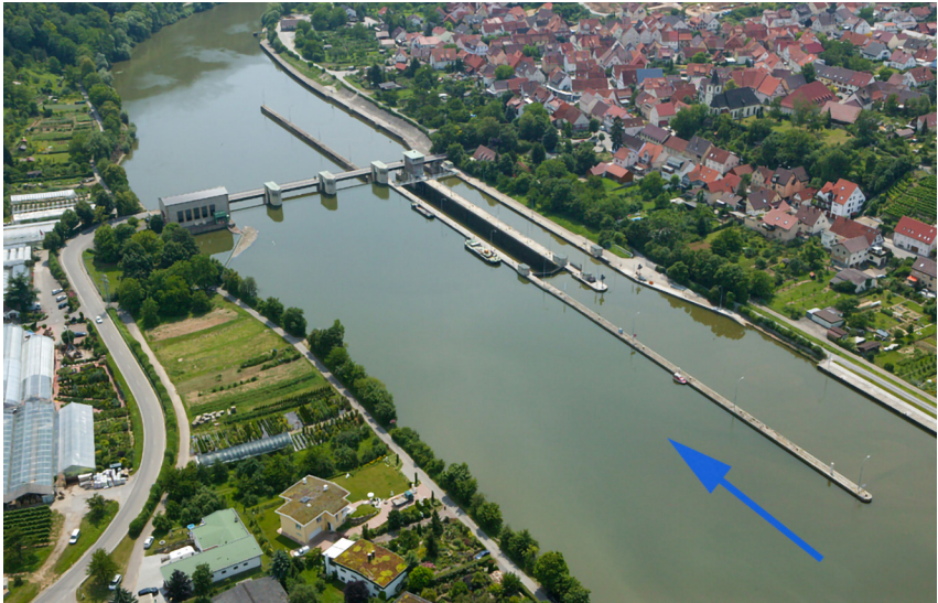
Abb. 1: Ansicht der Schleusenanlage Hessigheim. Die Anlage besteht aus zwei Schleusenkammern, einer dreifeldrigen Wehranlage sowie einem Kraftwerk.
